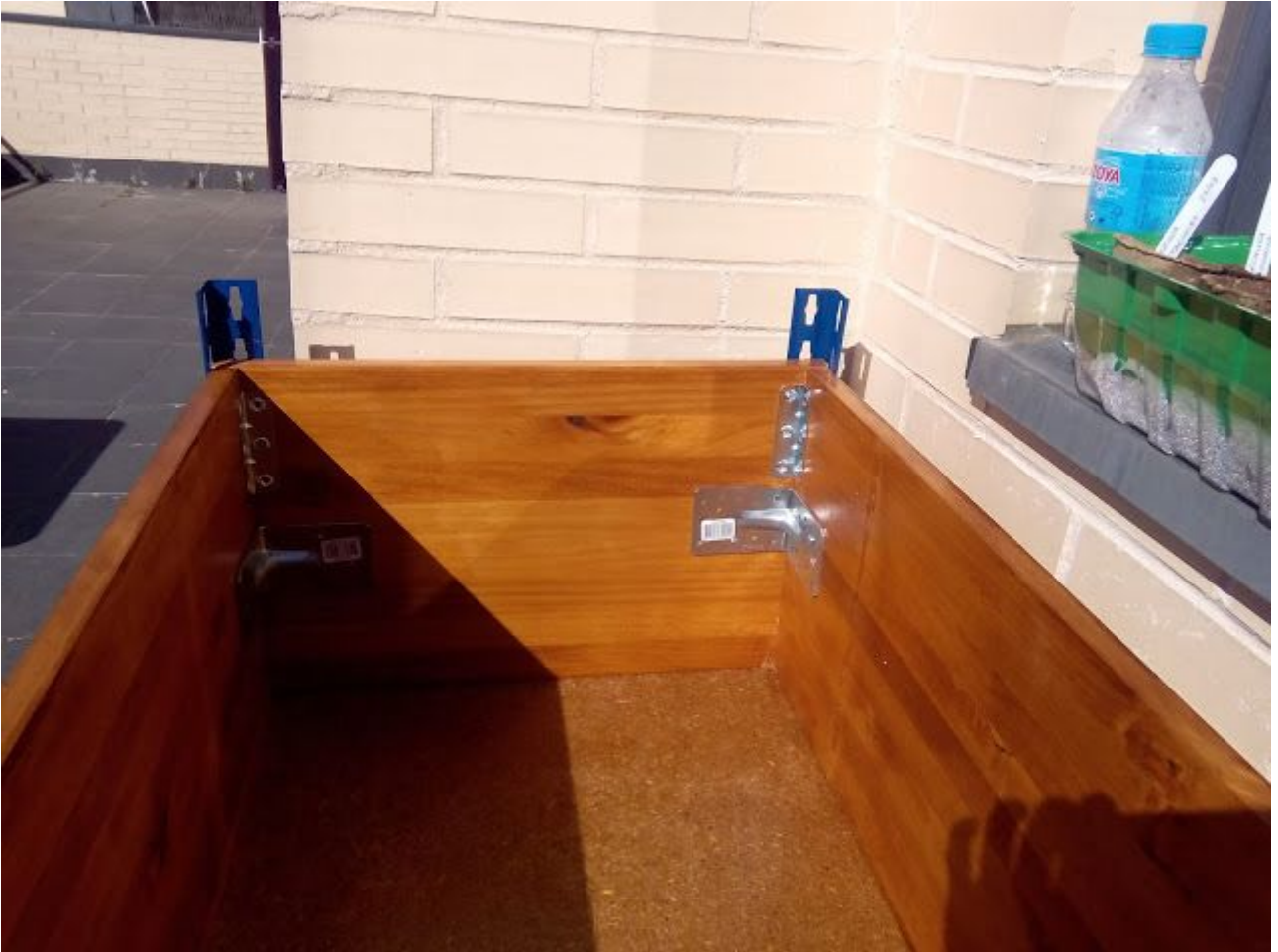
Cajón ya montado en la estantería con las escuadras colocadas
