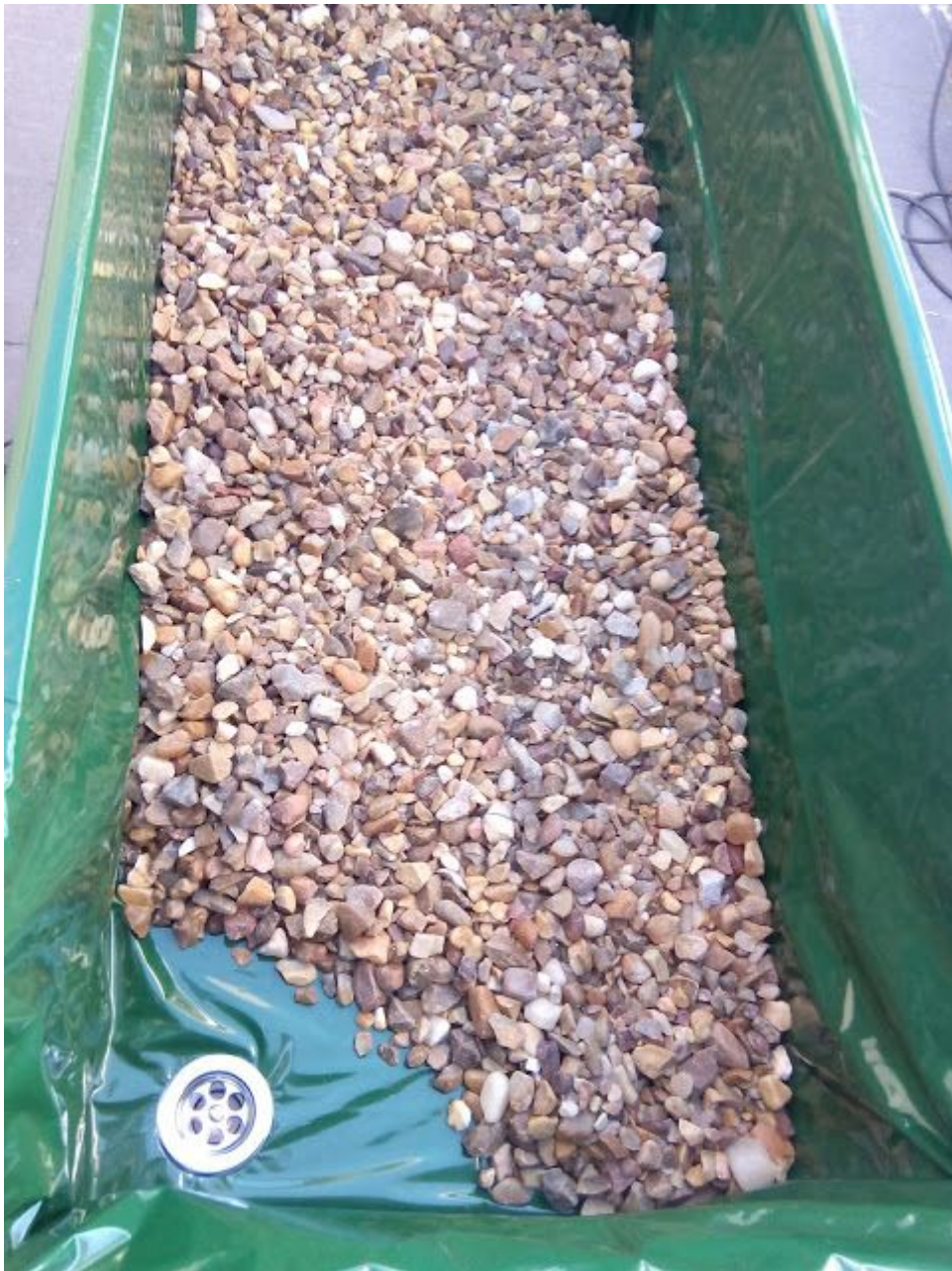
Desagüe y grava... correcto!
