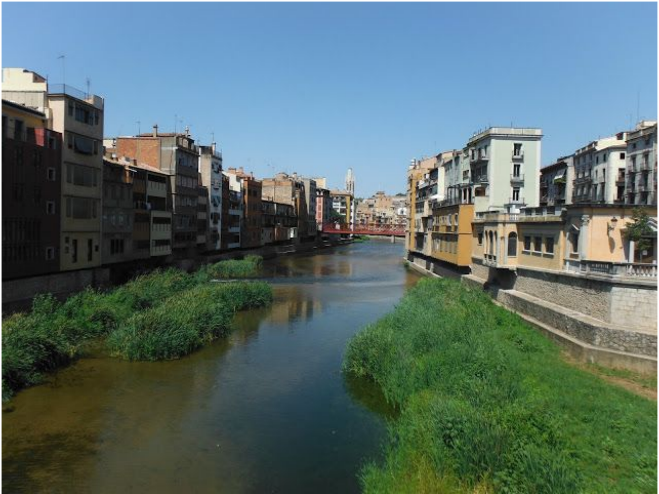
Puentes sobre el río Onyar
