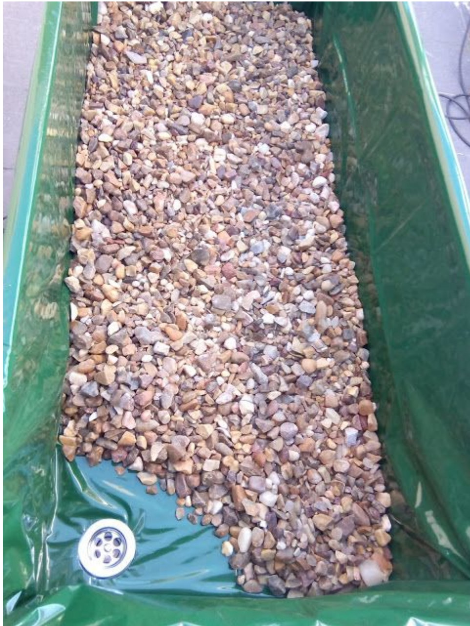
Desagüe y grava... correcto!
